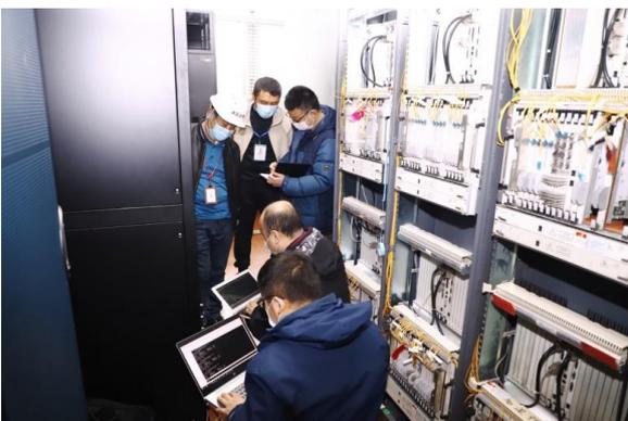
SA网络如期开通。4月21日，经过一天的紧急施工，项目团队完成了智能城域网和5G核心网全部设备软硬件安装调试，打通了A、B承载网、IPRAN核心等6条关键链路。4
