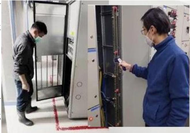
负载进行调整，同时积极为其实施降温方案，确保变压器安全稳定的运行。机房低压五路负载率最大，三相电流之和在 5500A 以上，低压进线柜内母排温度已达 65 度，在对其进行实施降温时，发现机柜门上自带的排风散热系统因其覆盖着一层较厚的过滤网，导致散热效果较差，机柜内热量无法及时排出，王静锋与维护人员一起拆除掉过滤网，让柜内热量及时散出，柜内母排温度明显降低。
