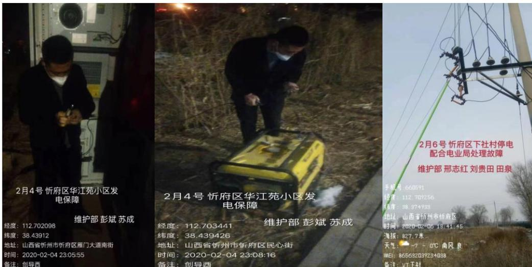
2月6日下午 13:30 忻府区下社村，由于供电局变压器故障，基站发生停电，直接影响移动移动 OLT 大面积宽带用户上网，公司立即组织精干力量，由片区负责人邢志红带队赶赴现场进行发电，并配合电业局维修员及时修复故障。
