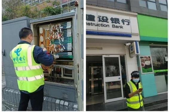
同日中午 12 点，武昌分部接到建行监控中心报建设银行省直支行社区自助银行业务故障。自助银行作为疫情期间重要的金融服务点，急需恢复业务使用。南湖片区 CEO 韩磊立即组织维护骨干单峰等人赶往用户点进行测试，修复自助设备。但监控中心称视频业务仍未恢复，测试光衰仍偏大。维护人员再从现场往局端逐段排查，最终判断为局端法兰盘光衰大，更换后联系监控中心确认恢复。用户对电信的高度责任感和细致服务表示感谢。
