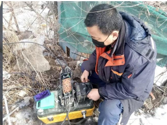
▲尚志市分公司光缆维护人员光缆抢修
