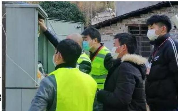
2月23日一大早，通城分公司组成12人的抢修精干力量，赶往四庄乡纸棚村抢修。翻山越岭架设临时通信光缆线路，将长达13公里的光缆接头、放缆、熔纤……直到下午两点，两个村的4G移动信号扩容抢修完成，测试网速畅通。
